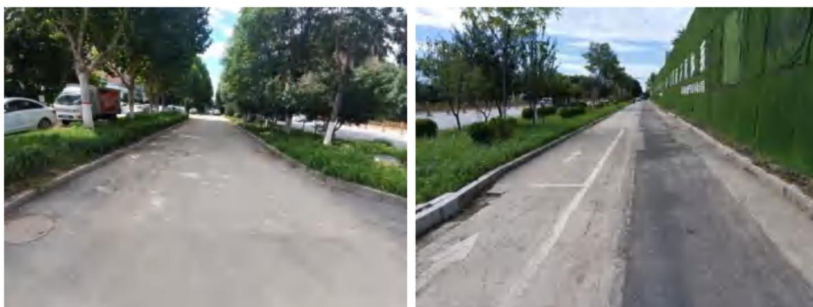
图 2.3-16 非机动车道面层网裂、坑槽
